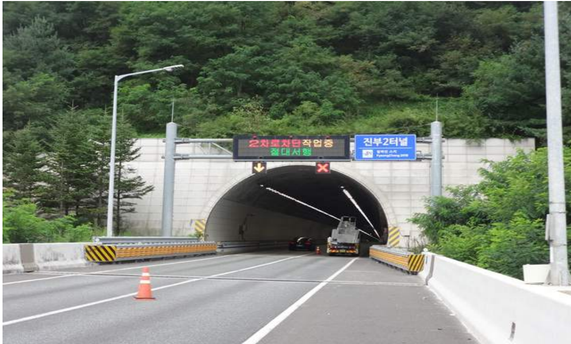
진부2터널(인천) 외부 전경
