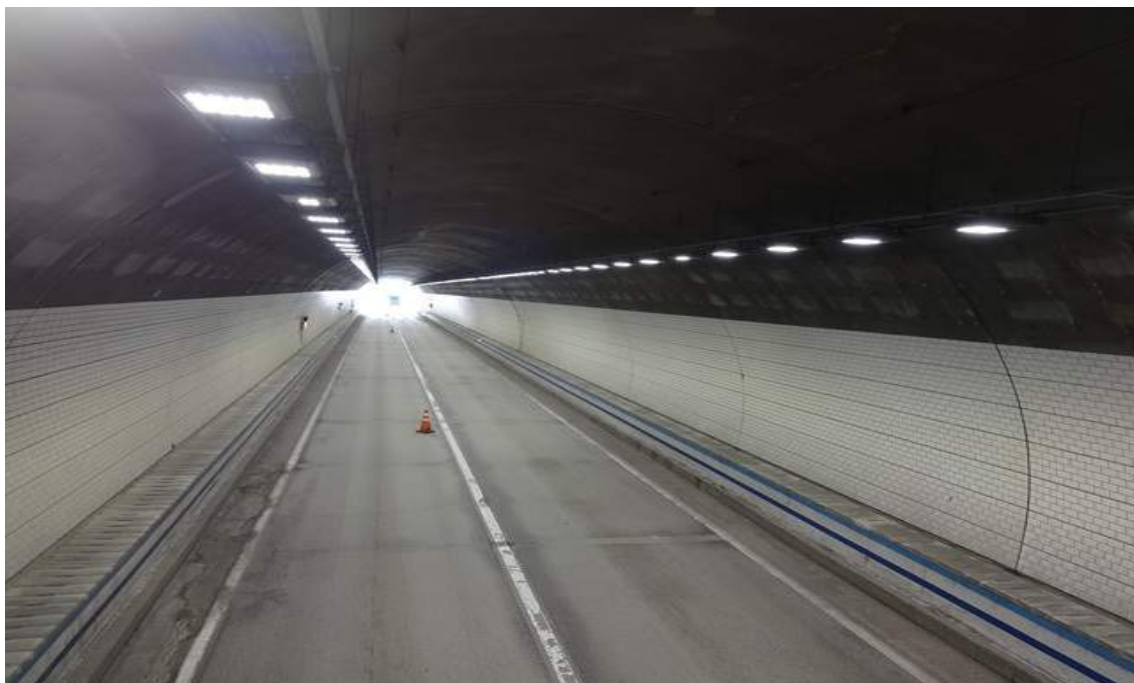
진부2터널(인천) 내부 전경
